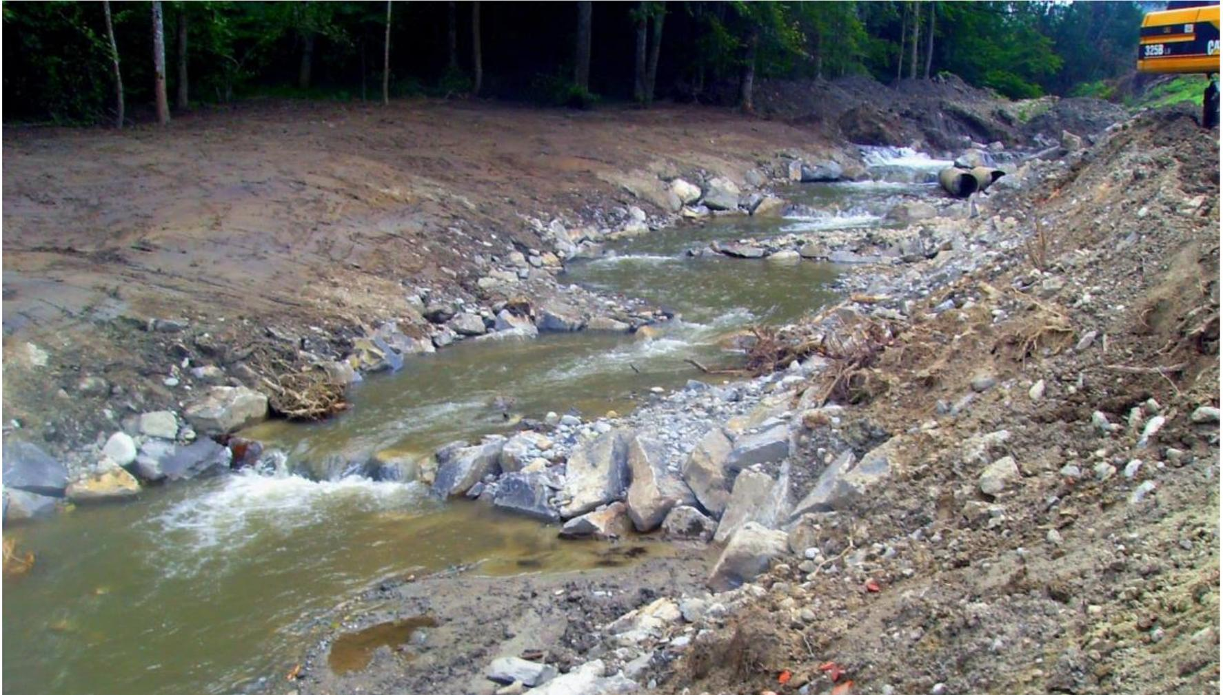
Die fertige Rampe bei Niedrigwasser. Durch die wechselseitige Neigung der Riegel wird das Niedrigwasser mäandrierend geführt (Fließwegverlängerung, bessere biologische Durchgängigkeit).
