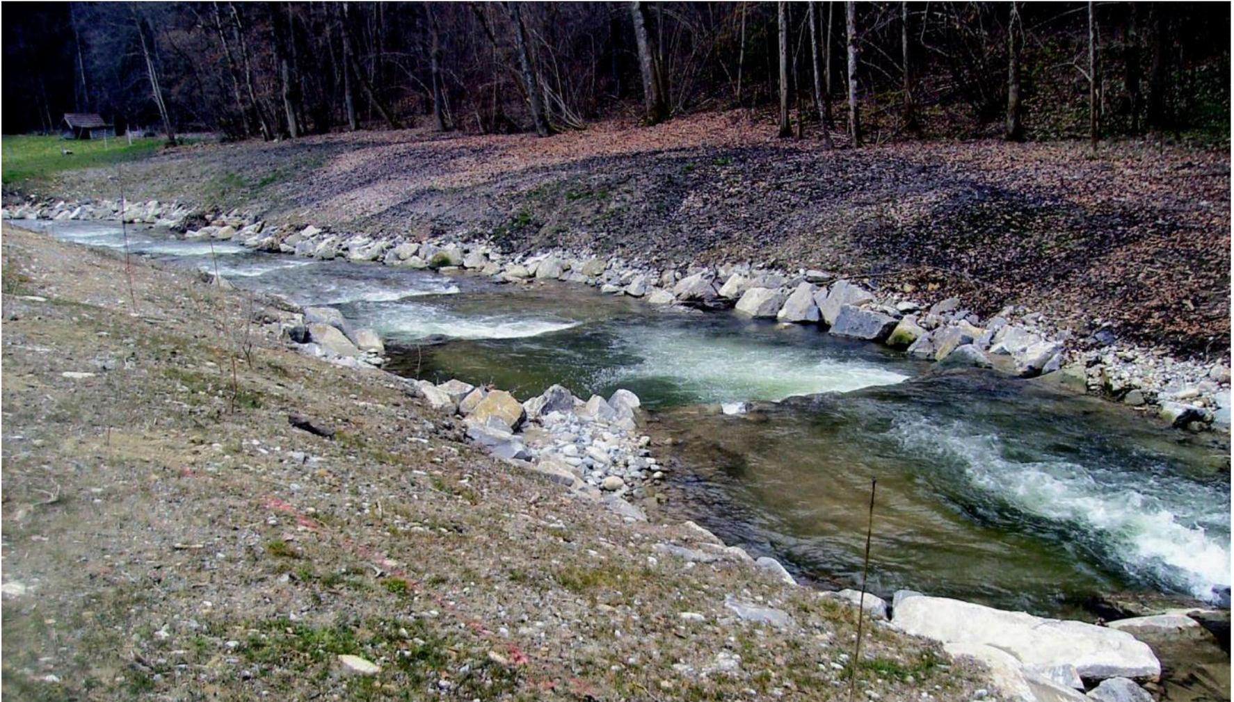
Die fertige Rampe bei Niederwasser. Durch die wechselseitige Neigung der Riegel wird das Niederwasser mäandrierend geführt (Fließwegverlängerung, bessere biologische Durchgängigkeit).
