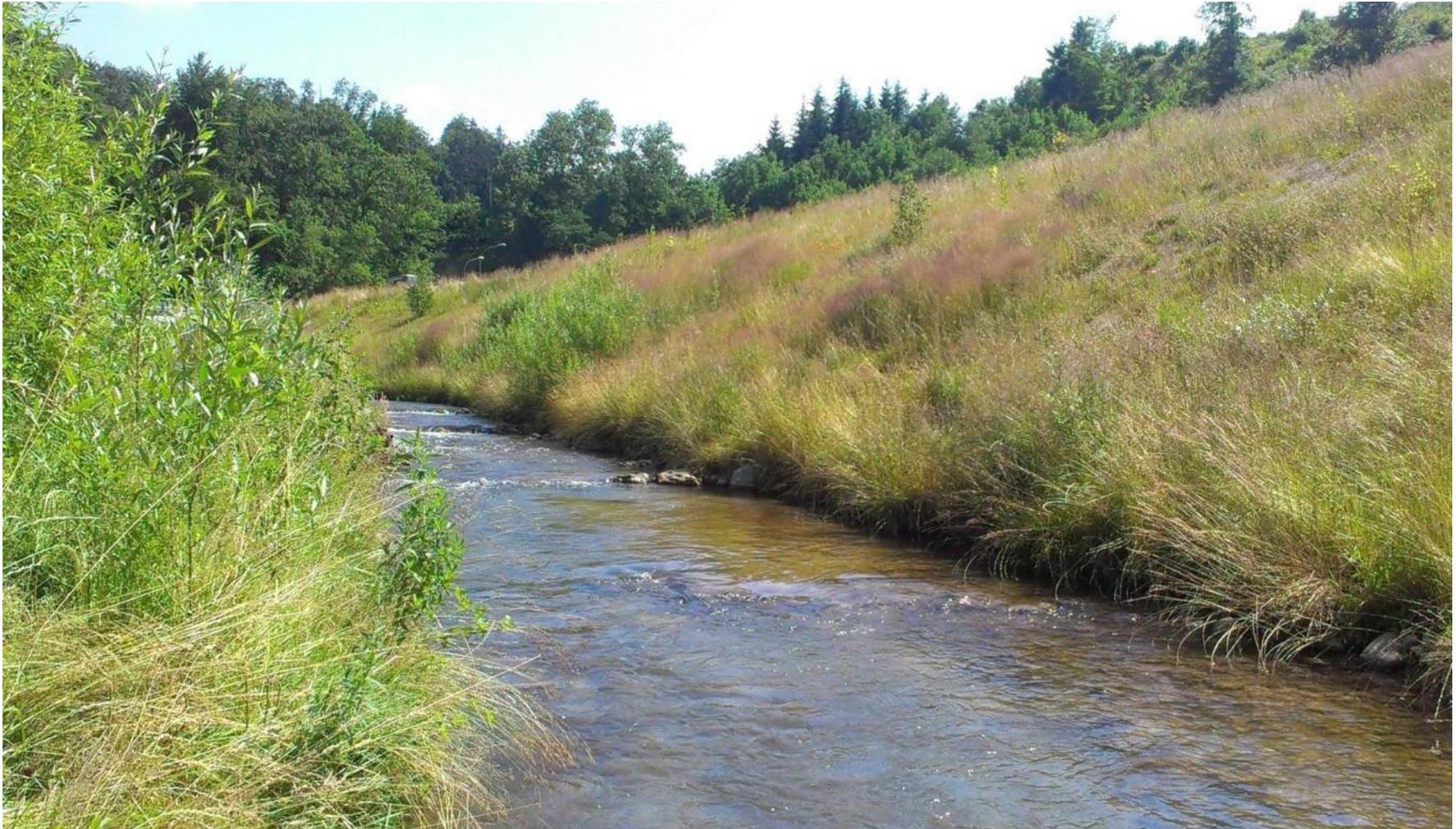
Neues Gerinne nach Bau, mit den relativ unauffälligen Lenkbuhnen in der Aussenkurve
