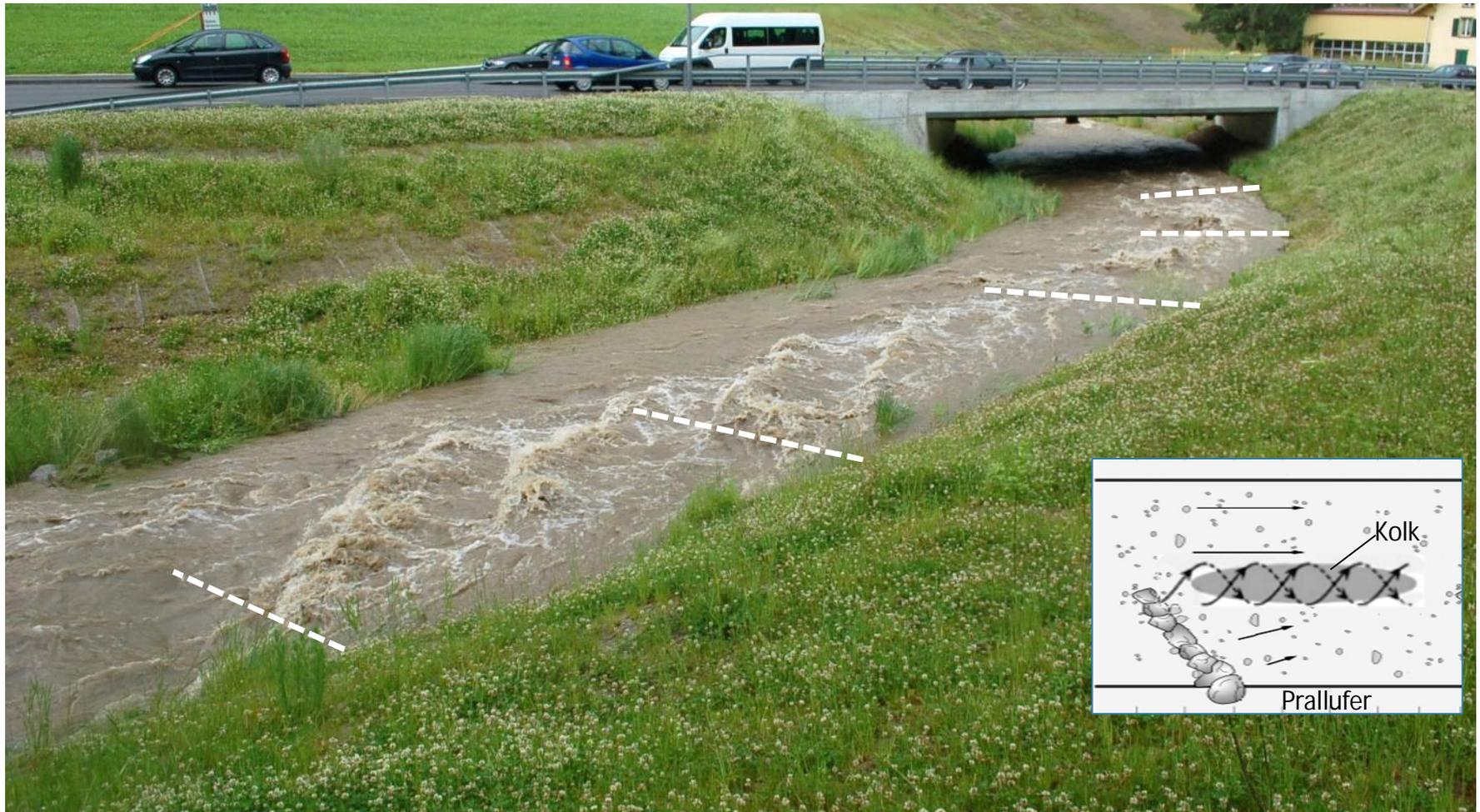
Flusskurve bei kleinem Hochwasser, die Buhnen (weiss markiert) sind hier etwa 80 cm hoch überströmt. Die von den Lenkbuhnen induzierte Spiralströmung ist deutlich sichtbar. Diese beruhigt die ufernahe Strömung, während mittig ein Kolk entsteht. Foto: Werdenberg; Schema: Sindelar & Mende (2009), adaptiert
