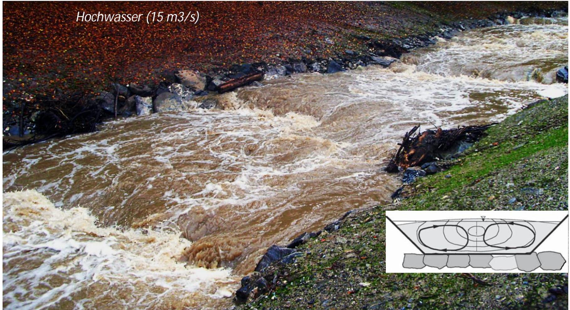
Ansicht bei kleinem Hochwasser, Riegel ca. 70 cm überströmt. Die Pendelrampe ruft bei starker Überströmung zwei Spiralströmungen hervor welche die ufernahe Strömung beruhigt und das Ufer entlastet.
