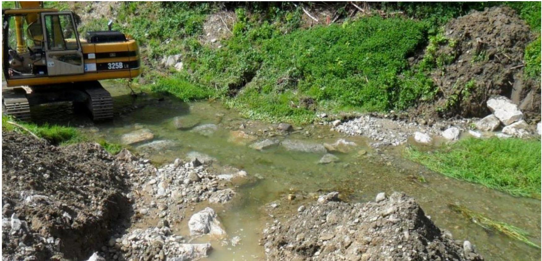
Entlang gerader Gerinneabschnitte wurden Trichterbuhnen eingebaut. Auf Uferlängsverbau wurde verzichtet.
