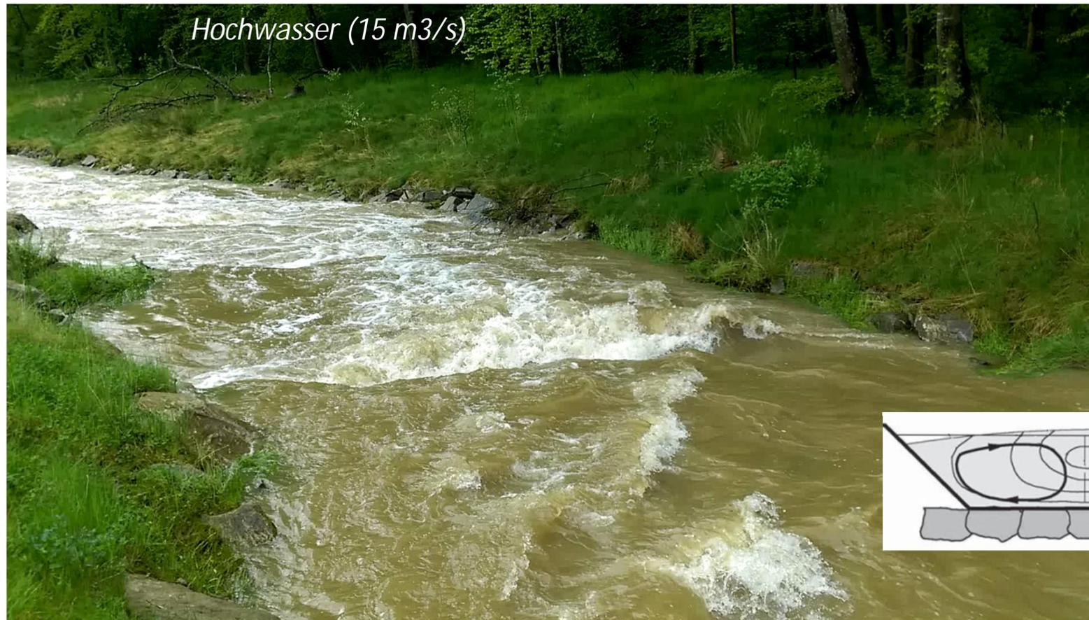
Ansicht bei kleinem Hochwasser, Riegel ca. 70 cm überströmt. Die Pendelrampe ruft bei starker Überströmung zwei Spiralströmungen hervor welche die ufernahe Strömung beruhigt und das Ufer entlastet.
