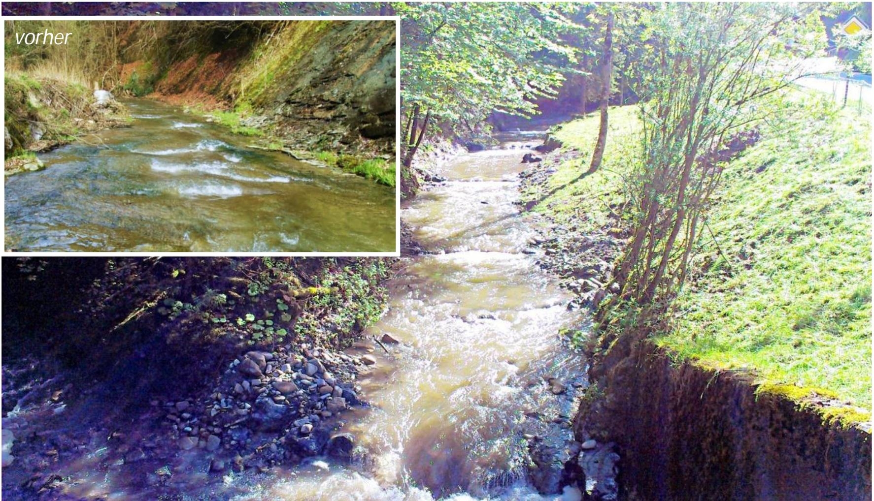
Das steile Gerinne verlief direkt auf Fels, auf dieser „Rutschbahn“ konnte sich kein Kies halten. Der Bachlauf wies dementsprechend wenige Lebewesen auf. Durch den Einbau von Lenkbuhnen und Pendelrampenartiger Querriegel konnte sich wieder eine Kiessohle aufbauen.
