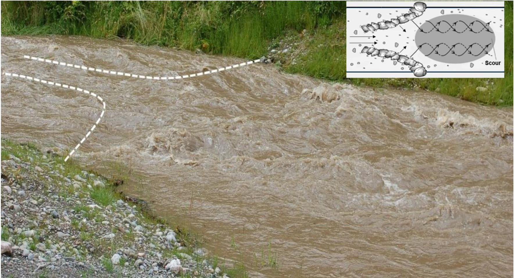
Ansicht eines Trichters (weiss gestrichelt) bei kleinem Hochwasser. Der Trichter ist etwa 80 cm hoch überströmt. Die zwei induzierten Spiralströmungen sind deutlich sichtbar, diese beruhigen die ufernahe Strömung, während mittig ein Kolk entsteht. Foto: Werdenberg; Schema: Sindelar & Mende (2009), adaptiert
